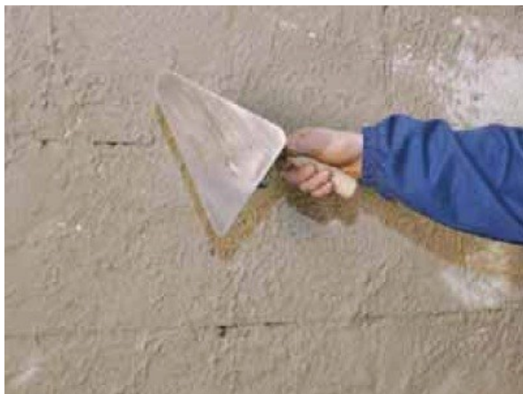
Рис. 1. Положение руки при нанесении обрызга.
